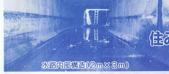
水路内部構造(2m×3m) 工事がすすむ1号幹線水路(瀬古製粉付近)
